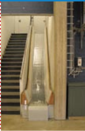
Liukumäen tarkoituksena on estää nilkkojen murtuminen siirryttäessä nopeasti miehistö tiloista paloautoihin.
